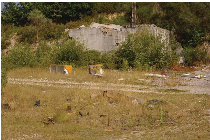
Canteirra abandonada con entullo
